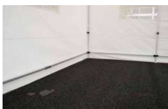
フレーム下部には補強フレームを接続
